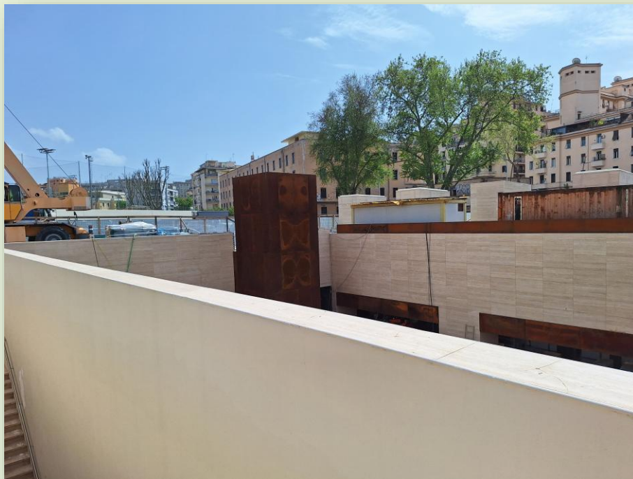
CANTIERE STAZIONE PORTA METRONIA
