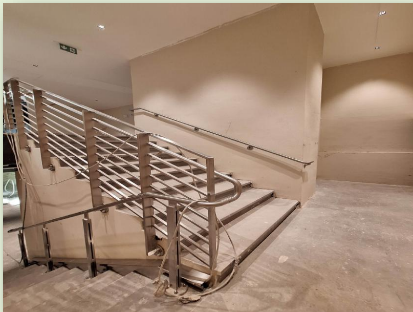
CANTIERE STAZIONE PORTA METRONIA
