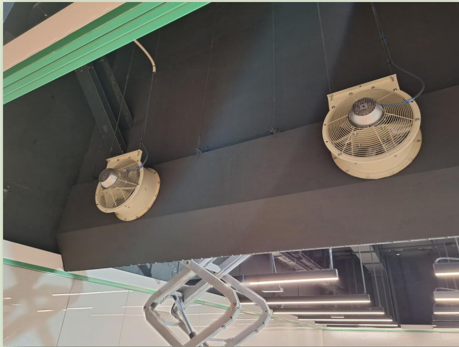
CANTIERE STAZIONE PORTA METRONIA
