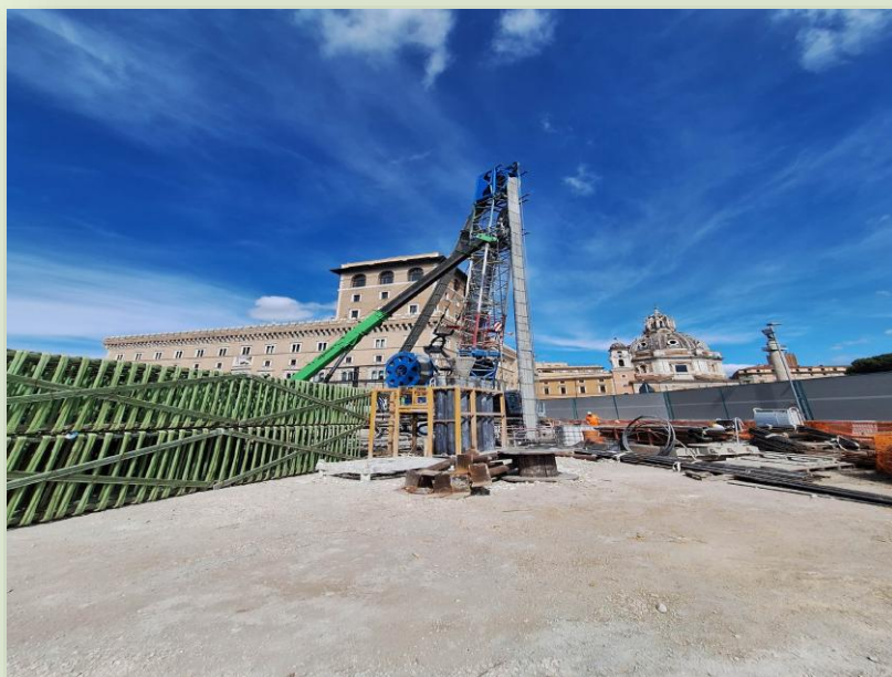
CANTIERE STAZIONE VENEZIA
