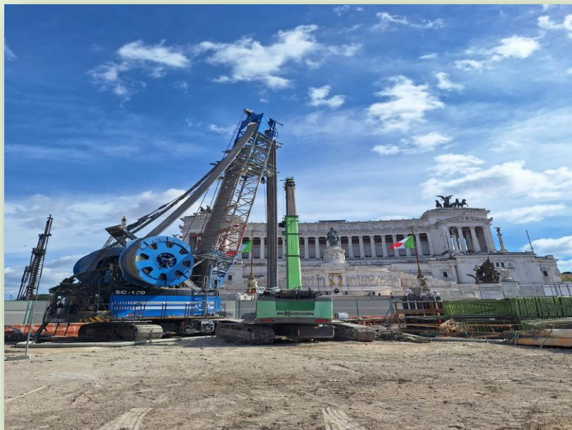
CANTIERE STAZIONE VENEZIA
