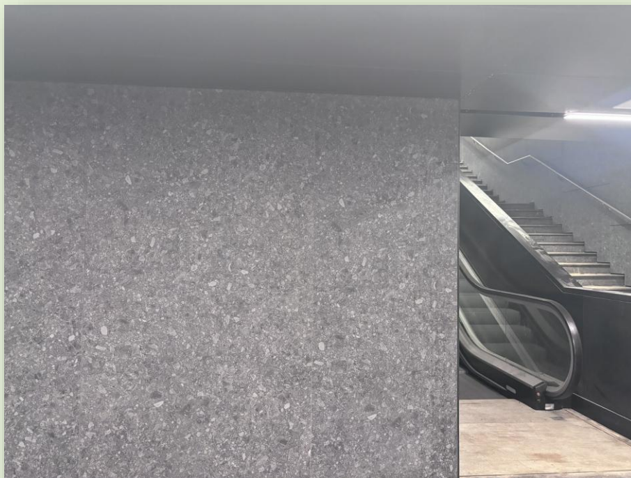
CANTIERE STAZIONE COLOSSEO (FORI IMPERIALI)
