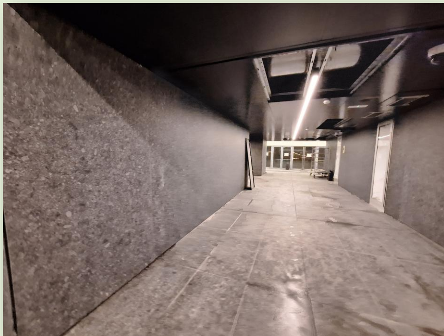
CANTIERE STAZIONE COLOSSEO (FORI IMPERIALI)
