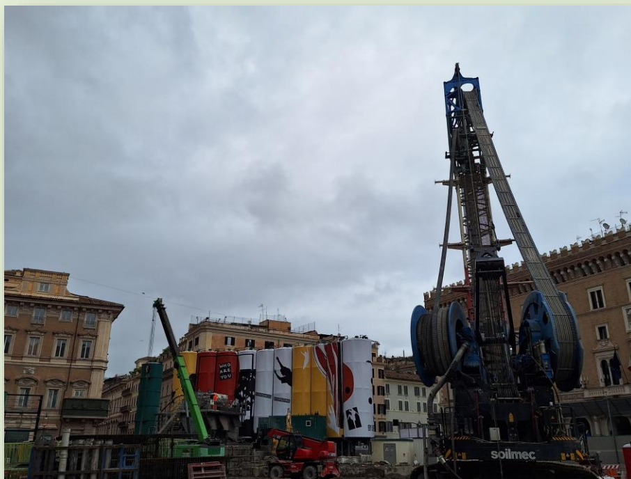
CANTIERE STAZIONE VENEZIA
