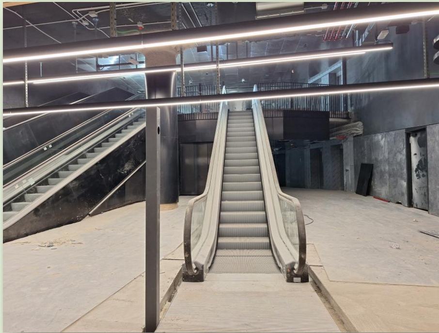
CANTIERE STAZIONE COLOSSEO (FORI IMPERIALI)
