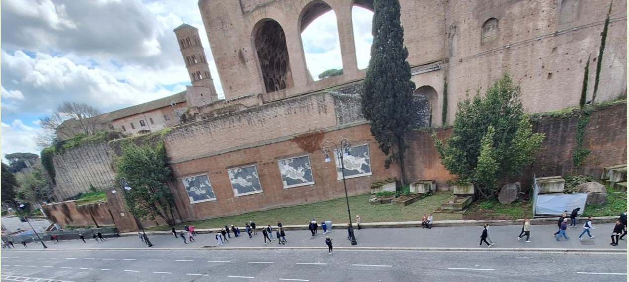
CANTIERE STAZIONE COLOSSEO (FORI IMPERIALI)
