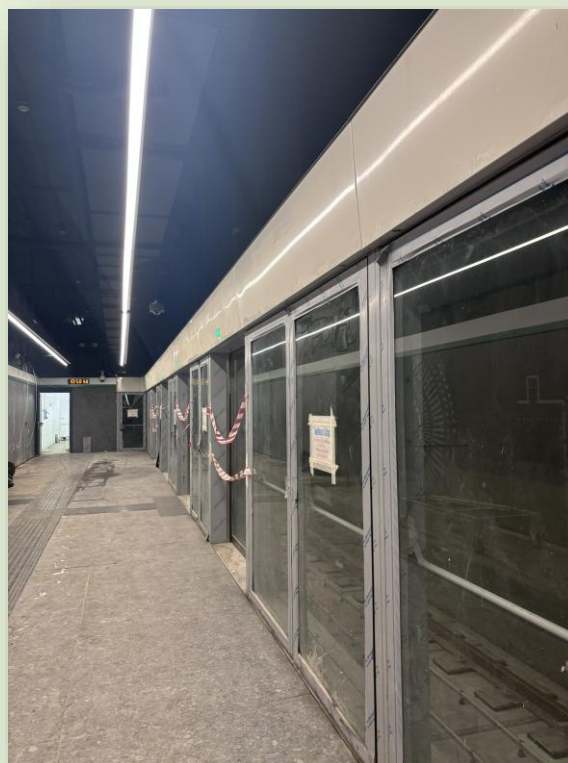
CANTIERE STAZIONE COLOSSEO (FORI IMPERIALI)
