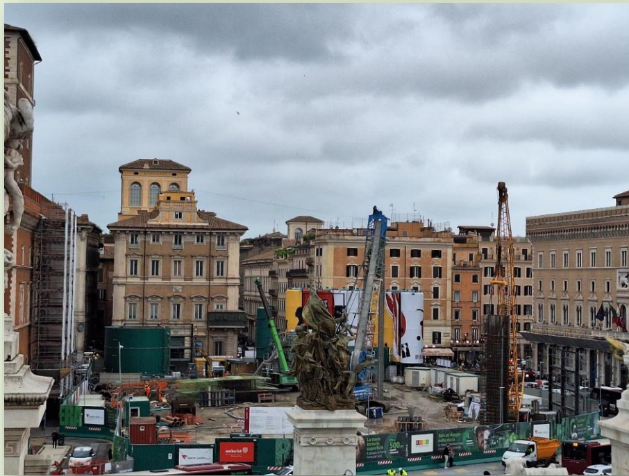
CANTIERE STAZIONE VENEZIA
